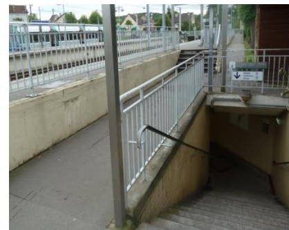
Accès au quai 2 par un sous-terrain ou un passage en bout de quai
