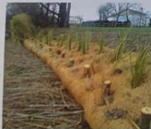
Exemple de fascines d'héliophytes, à la pose et quelques mois après
