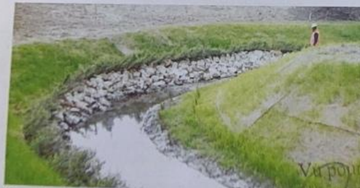
Exemples d'enrochements en confortement de berge
