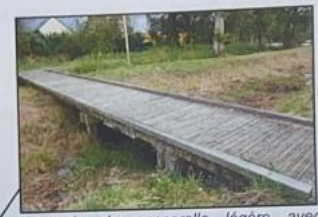
Exemple de passerelle légère avec chasse-roues.
