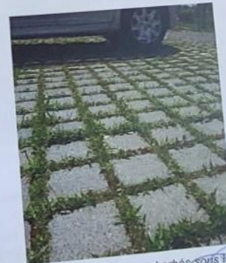
Pavés béton à joints enherbés sous les places de parking
