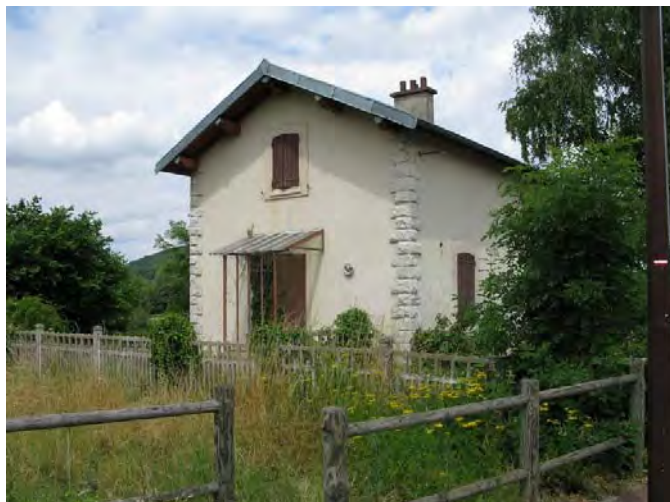
Maison du garde barrière actuelle
